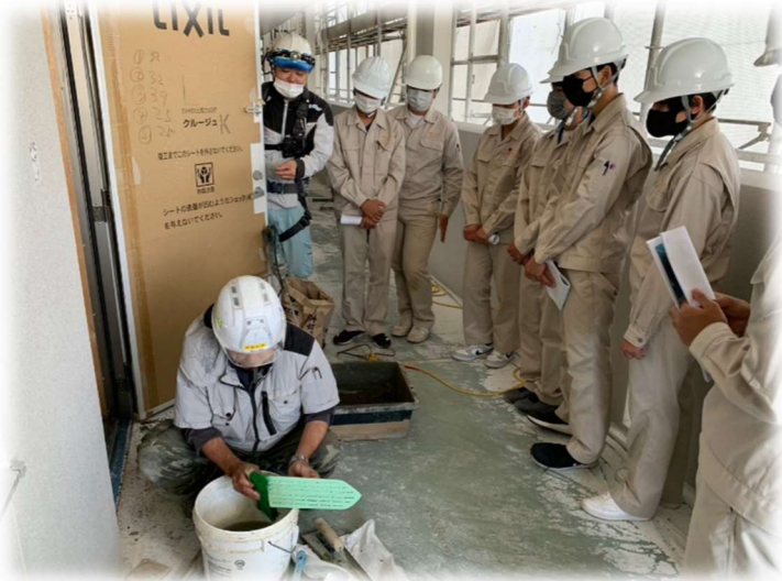
職人の説明を聞いている様子① 宇栄原市営住宅(那覇市)
