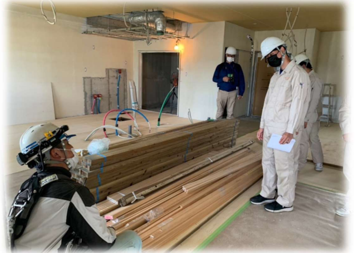
職人の説明を聞いている様子③ 宇栄原市営住宅(那覇市)
